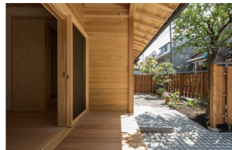
防火構造の落とし込み板壁の事例
